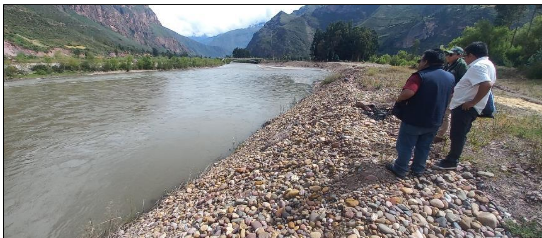
FIGURA N°01: FIGURA N°01: BASE DEL TALUD DEL RIO SE OBSERVA EL SOCAVAMIENTO Y EROSION DEL MISMO EL CUAL DEBILITA Y PODRIA AFECTAR EL PUENTE Y AREAS DE CULTIVO.
