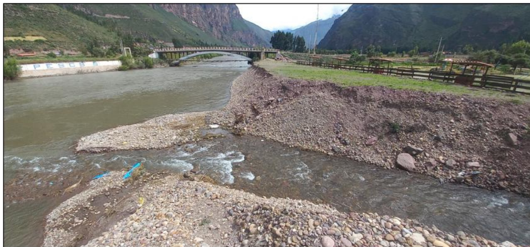
FIGURA N°03: BASE DEL TALUD DEL RIO SE OBSERVA EL SOCAVAMIENTO Y EROSION DEL MISMO EL CUAL DEBILITA Y PODRIA AFECTAR EL
