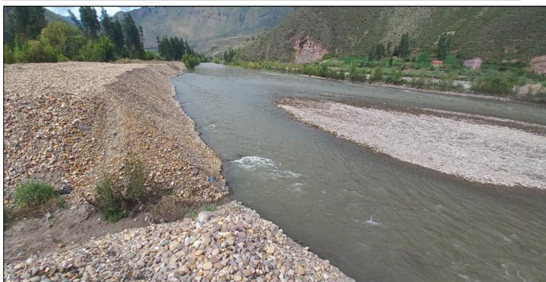
FIGURA N°02: BASE DEL TALUD DEL RIO SE OBSERVA EL SOCAVAMIENTO Y EROSION DEL MISMO EL CUAL DEBILITA Y PODRIA AFECTAR LOS TALUDES DEL CAUCE DEL RIO VILCANOTA.
